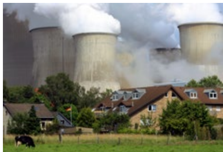
Gärten im Einzugsbereich von Schwerindustrieanlagen können erhöhte Schadstoffwerte im Boden aufweisen
